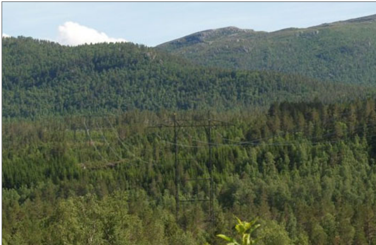
Figur 21: Bilde av kamuflert kraftledning. Linene er mattet, og isolatorene er av kompositt i stedet for av glass som er vanligst å benytte.
