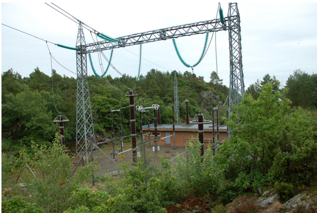
Figur 10: Muffeanlegg for SK1-3 ved Kvarenes. Muffeanlegget er inngjerdet med et ca. to meter høyt gjerde.
