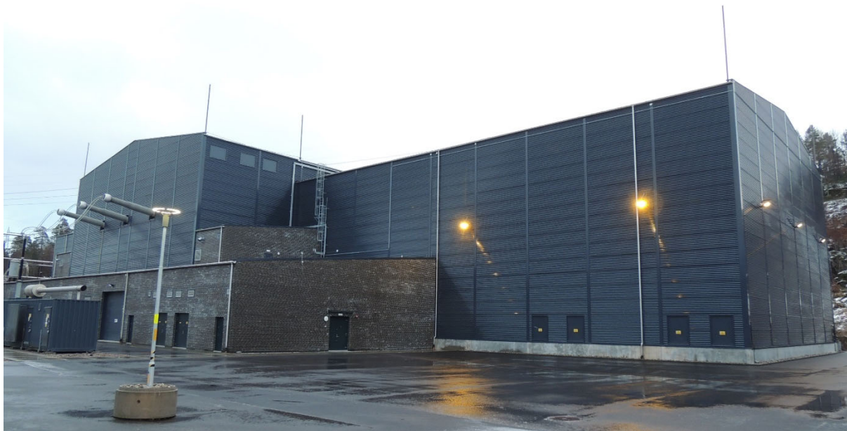
Figur 5: Strømretteranlegg for SK4 i Kristiansand transformatorstasjon
