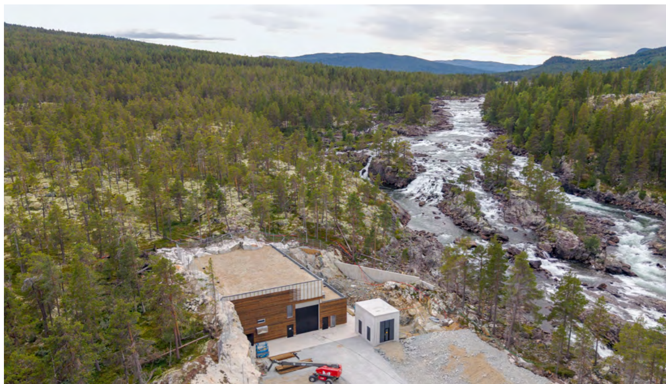
I august ble Godfarfoss kraftverk, som er bygget øverst i Numedalslågen i Buskerud, offisielt åpnet. Det vil årlig produsere 40 GWh, som dekker energibehovet til rundt 2.500 boliger. Å Energi eier kraftverket sammen med Hol kommune og Nore og Uvdal kommune.
