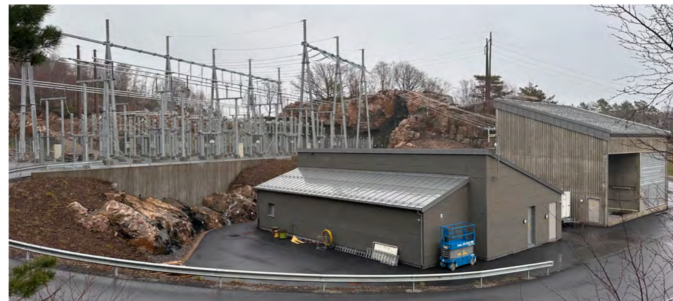
Glitre Nett har bygget ny transformatorstasjon ved GE Healthcare i Ramslandsvågen i Lindesnes. Økt tilgang på kraft er avgjørende for at GE Healthcare kan utvide produksjonen og ta i bruk ny teknologi som vil redusere bedriftens klimagassutslipp.
