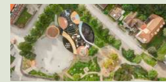
Oppgradering av Buranbanen Agraff Arkitektur og Trondheim kommune
