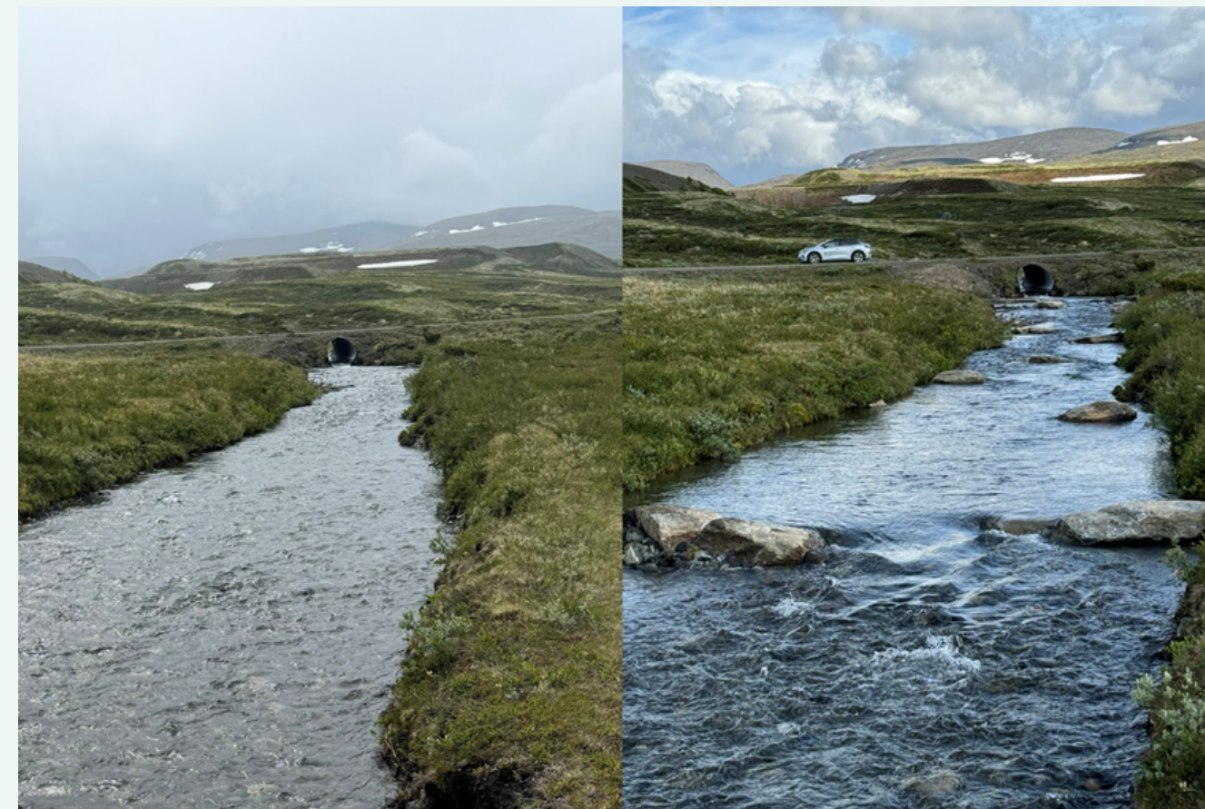
Før (venstre) og etter (høyre) steinutlegging i øvre deler av tiltaksområde.
