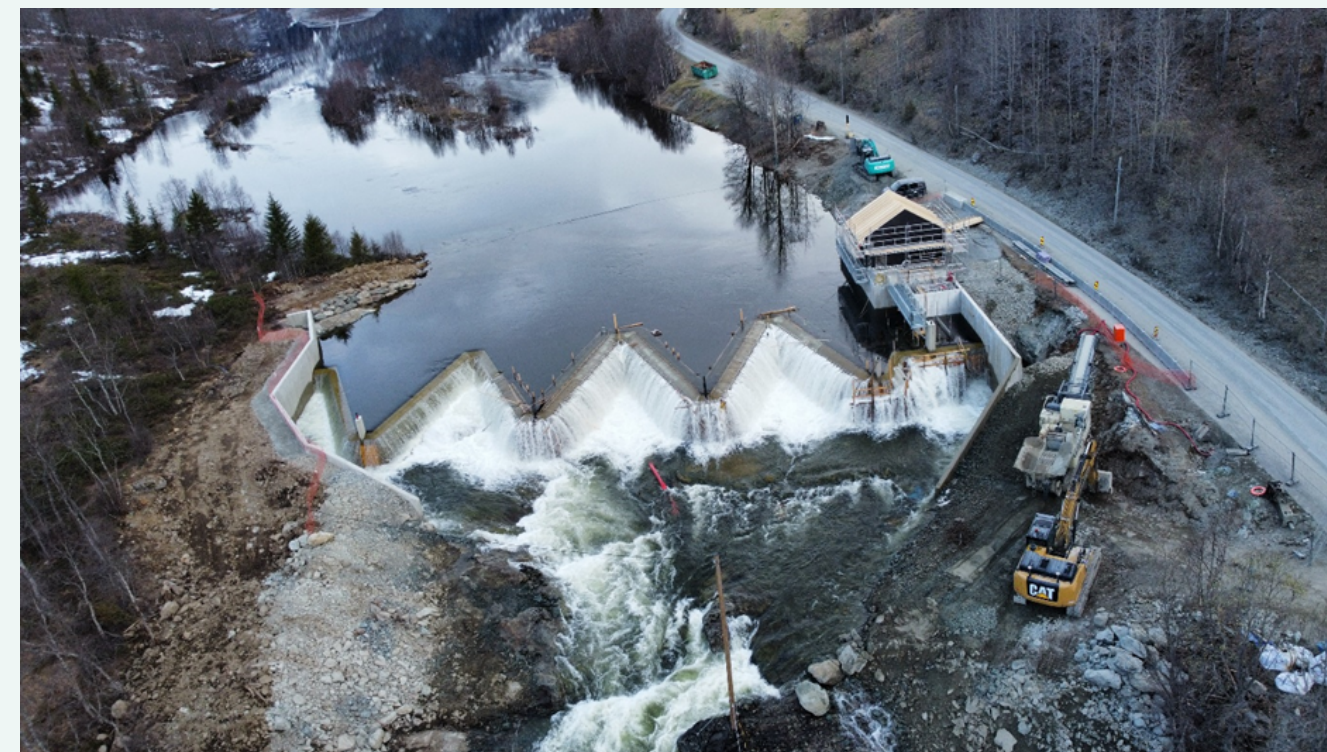
Anleggsarbeider ved dam Flatsjø. Bildet viser arealbruk i anleggsfasen. Midlertidige arealer istandsettes ved ferdigstilling.
