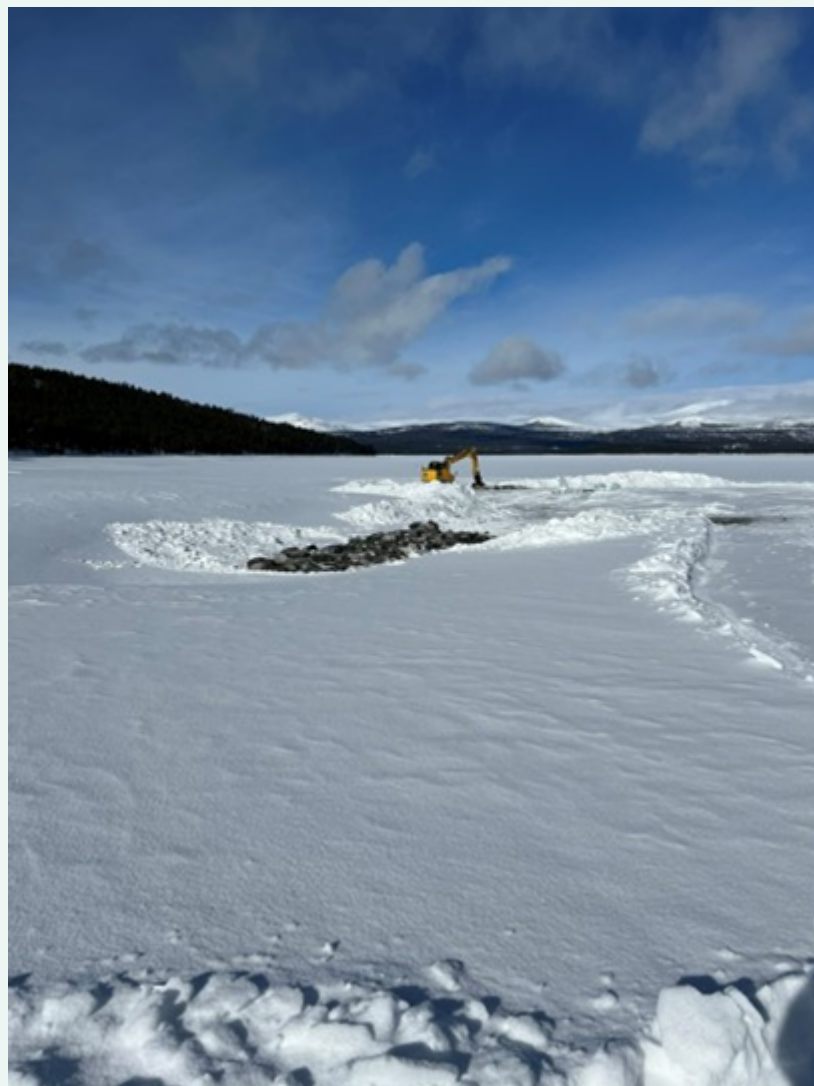
Bildet viser steinutlegging i reguleringssonen i Savalen.
