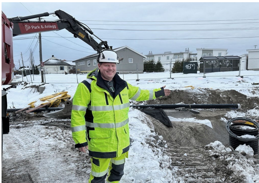
Fjernvarmerør legges i bakken på Grålum
