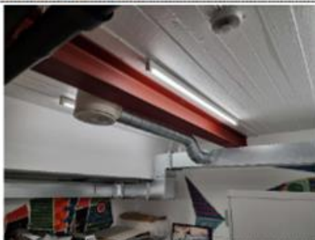
B-090 Stålförsterking i magasinrom av dekke under utstilling.
