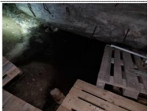
B-051 Stående vann i krypkjeller under Rotunden
