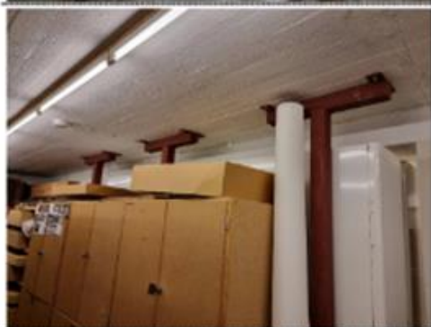
B-086 Stålförsterking i magasinrom av dekke under utstilling.
