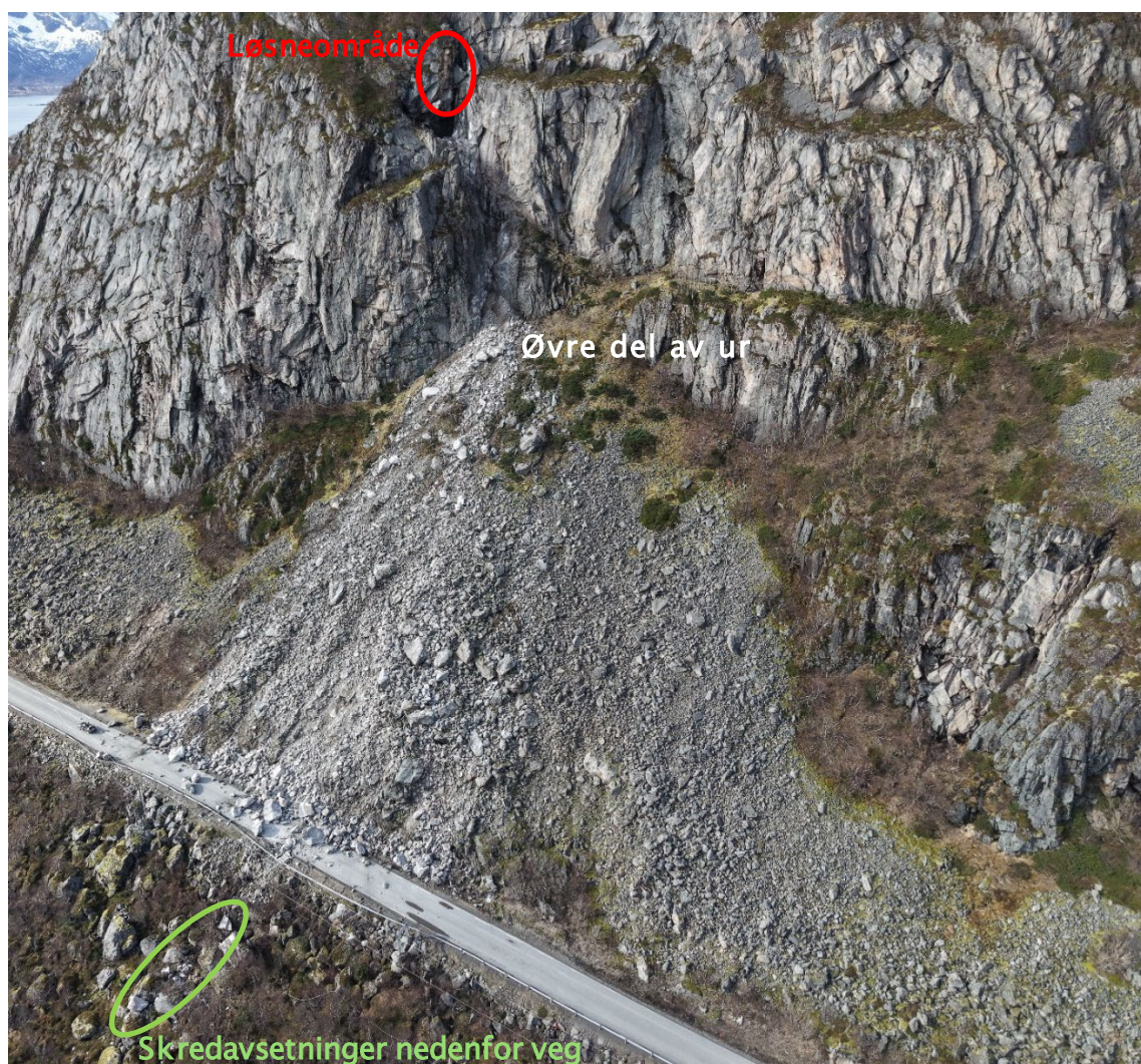
Figur 1: Oversiktsbilde fra skredområdet til steinskredet 23.04.2025.
