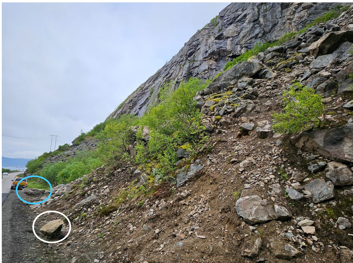
Figur 4: Blokker som har kommet i grøft i løpet av juni 2025.
