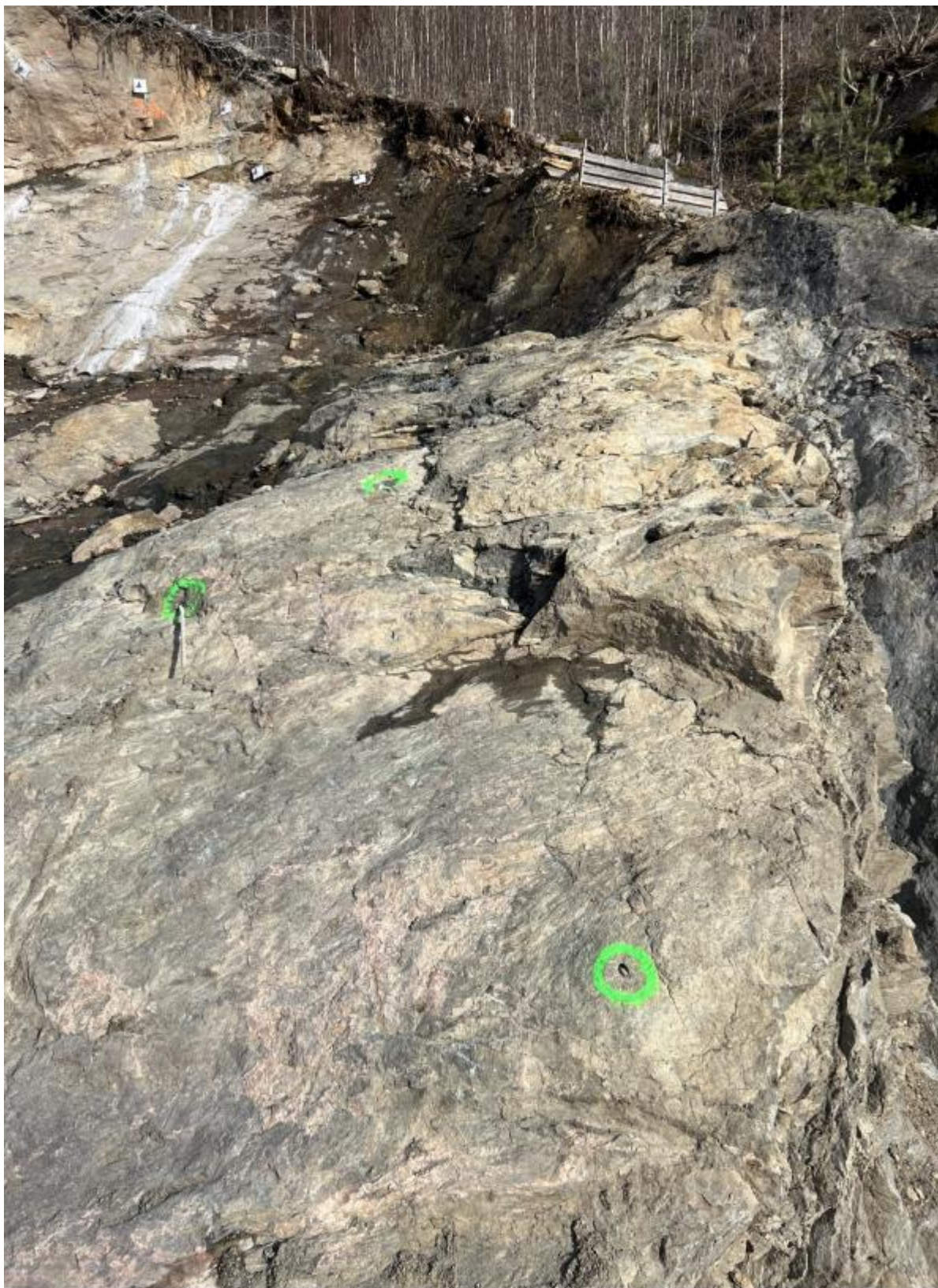
Figur 8-5. Spor av tre bolter er markert med grønt. Alle er bolter som har gått til brudd: det er ingen som har blitt dratt ut av forankringssonen.
