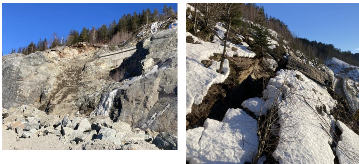
Figur 3-1. Foto fra befaring 17.02.2025. Venstre: sett fra E6. Høyre: sett mot sør fra lift.
