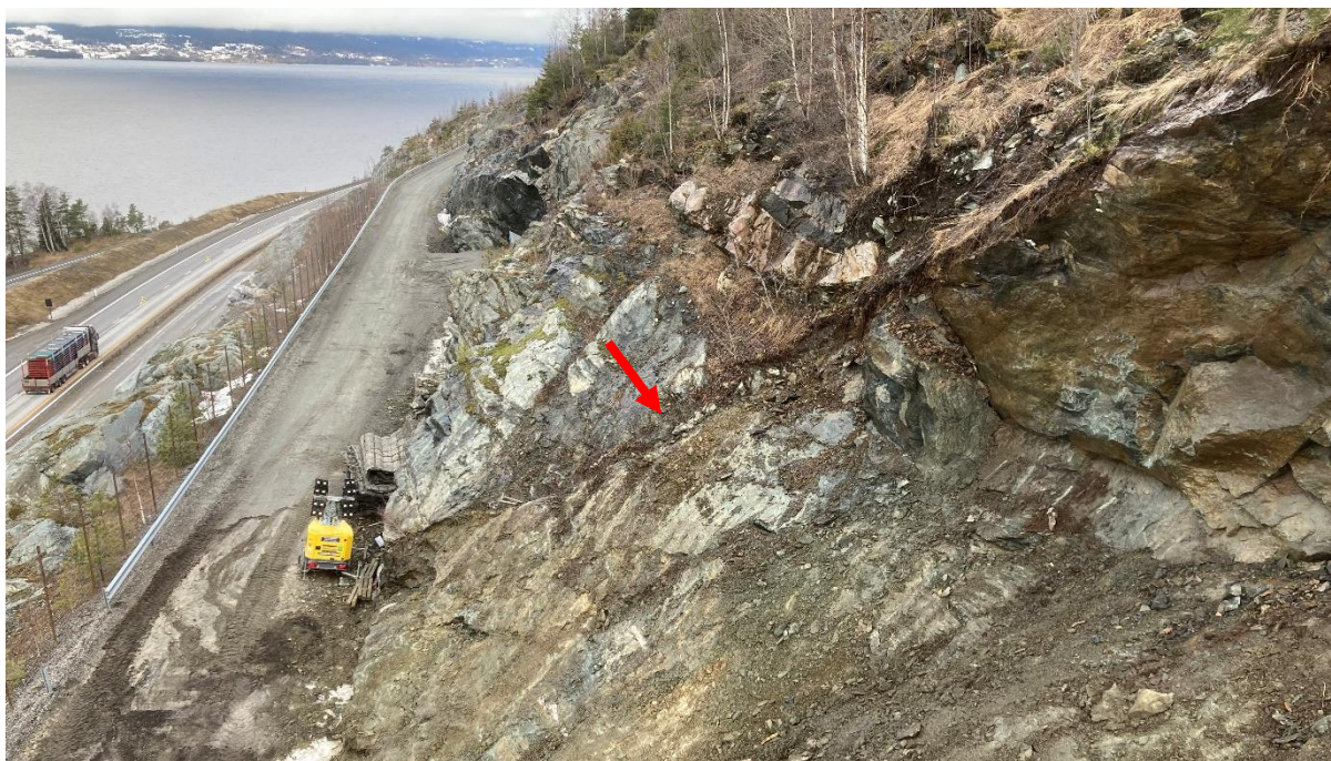
Figur 2-5. Oversiktsbilde fra lift. Rød pil peker mot utgående av en knusningssone / forkastning som tilsynelatende avgrenser glideflata mot nord. Merk avbøyning av felsisk foliasjons-parallell gang inn mot forkastningen.
