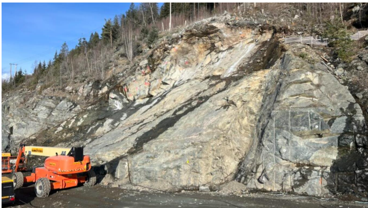
Figur 8-3. Spor av vann på glideflaten (mørke felter) noen dager etter regnvær.
