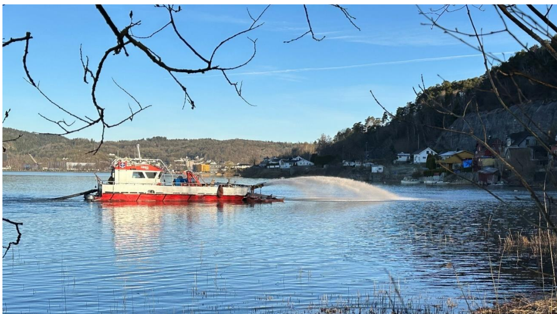
Figur 2-16: Tildekking av grunne områder med rainbowing.
