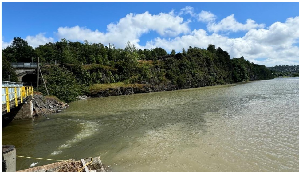
Figur 8-5: Boblegardin mellom jernbanebru ved utløp nord
