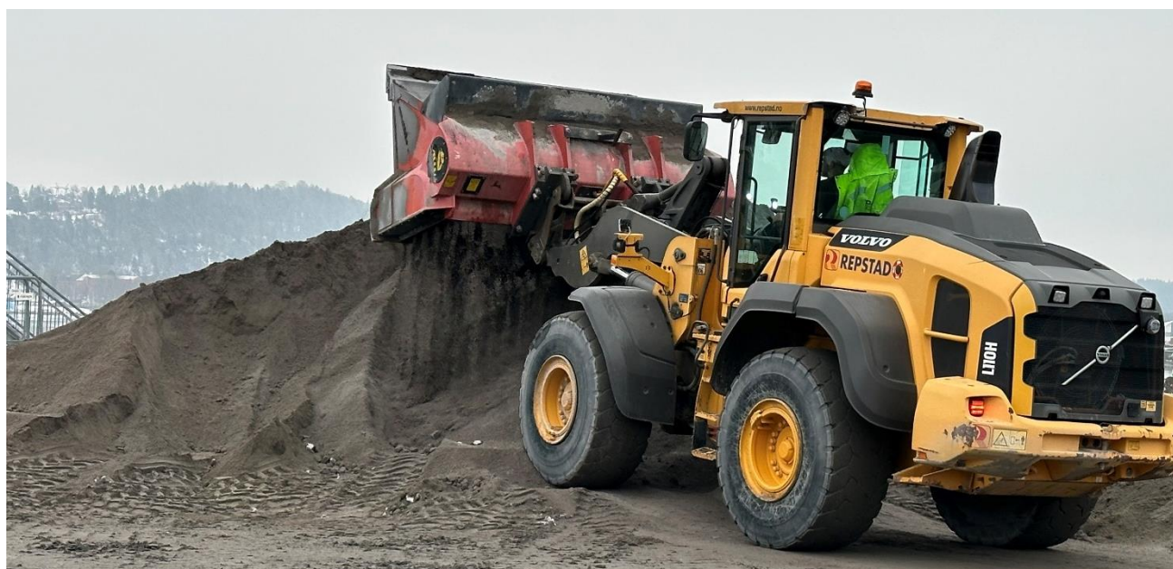
Figur 8-3: Bruk av hjullaster med soldeskuffe for å fjerne isklumper i massene
