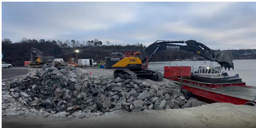
Figur 2-6: Påfylling av lektre fra lastekai
