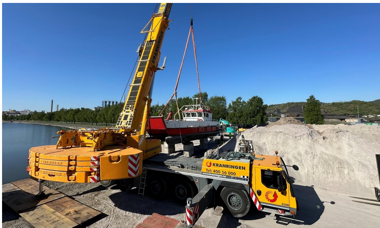
Figur 8-2: Innheising av båt og mellomlagring av tildekkingsmasser
